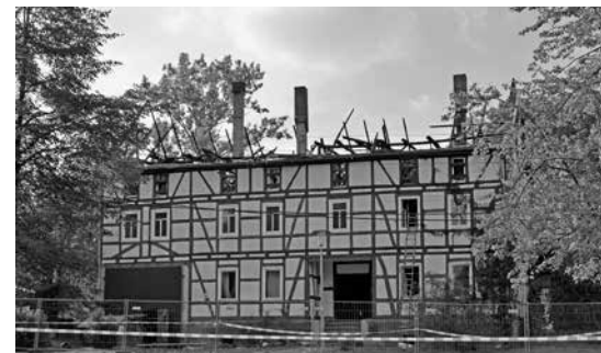
Eine Woche später wären hier Menschen verbrannt. Ruine der niedergebrannten Flüchtlingsunterkunft in Bischhagen.
