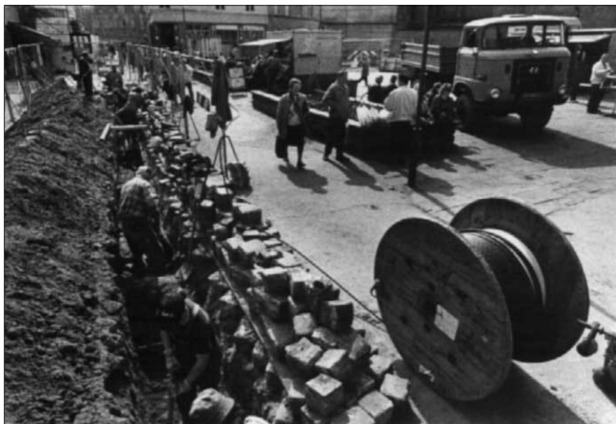
Kabelarbeiten der Telekom (in Güstrow): „Daten zu Digitalbrei“
